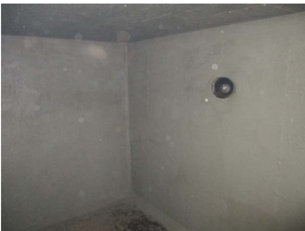
Abb. 4.10: beschichtete Wand und Decke
