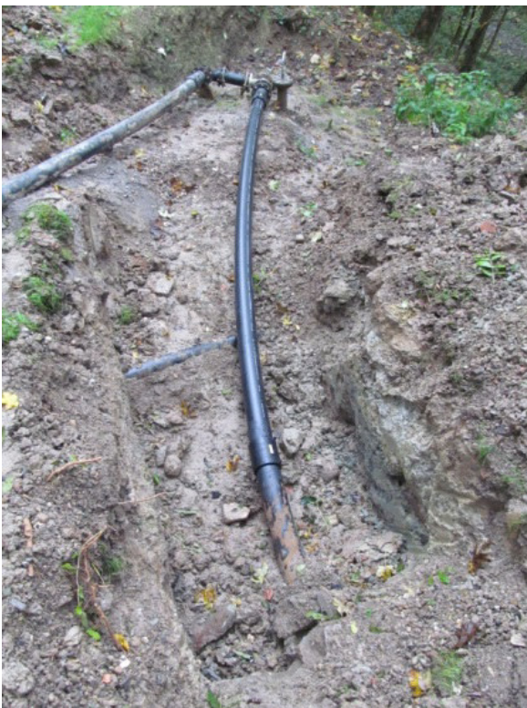
Abb. 4.5: neu verlegte PE-Leitung
