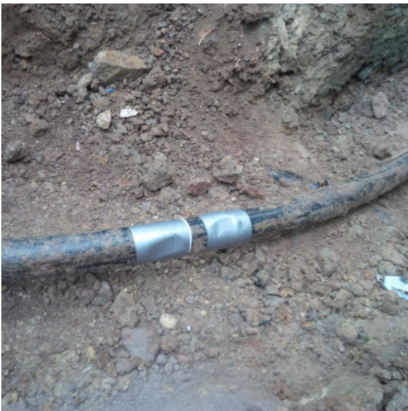
Abb. 4.3: Leckage Gasleitung
