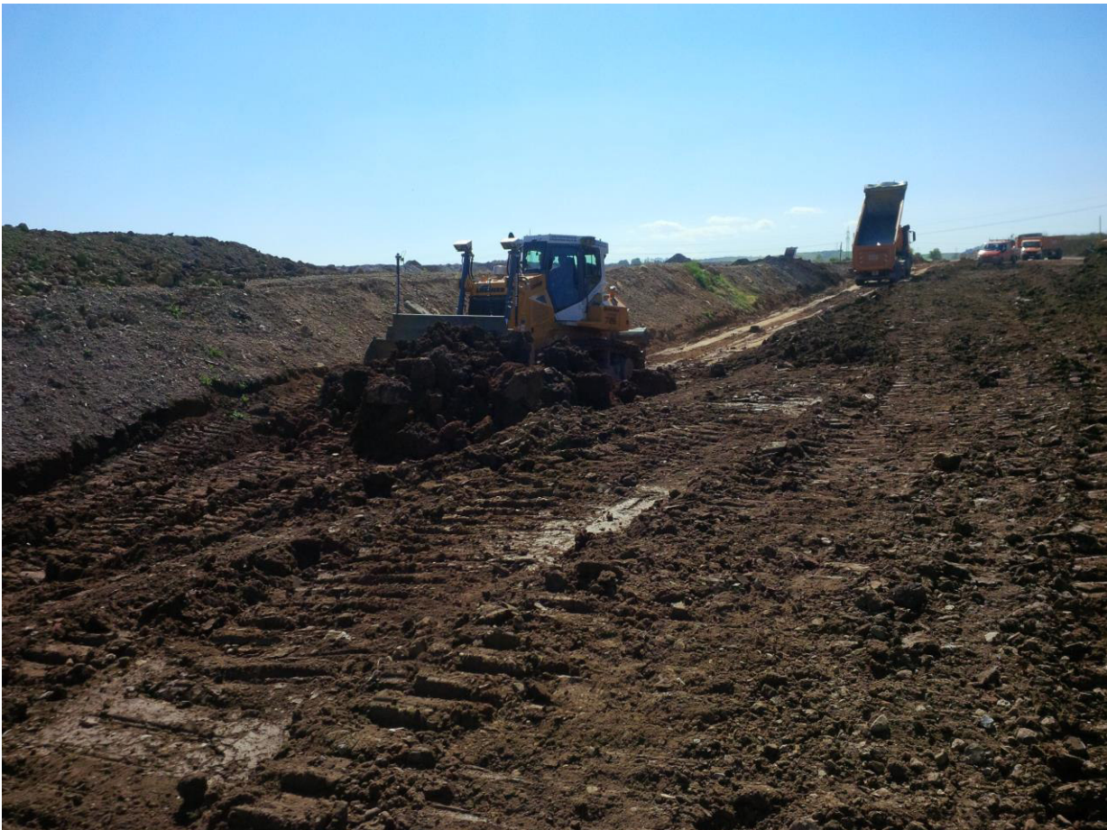
Abb. 4.1: Materialeinbau am Trenndamm TD 4
