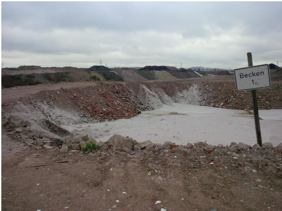
Abb. 4.2: Becken 1 für die Ablagerung konditionierter Schlämme
