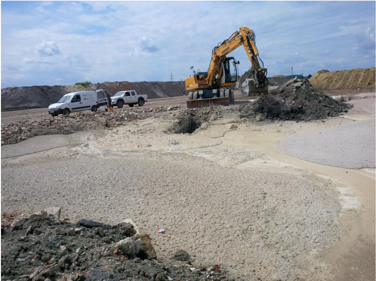
Probenahme aus einem Lagerbereich für schlammige Abfälle
