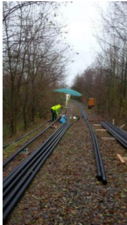
Abb. 4.11: Stumpfschweißen der Gasleitungen
