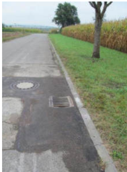
Abb. 4.9: Ausgebesserter Versickerungseinlauf
