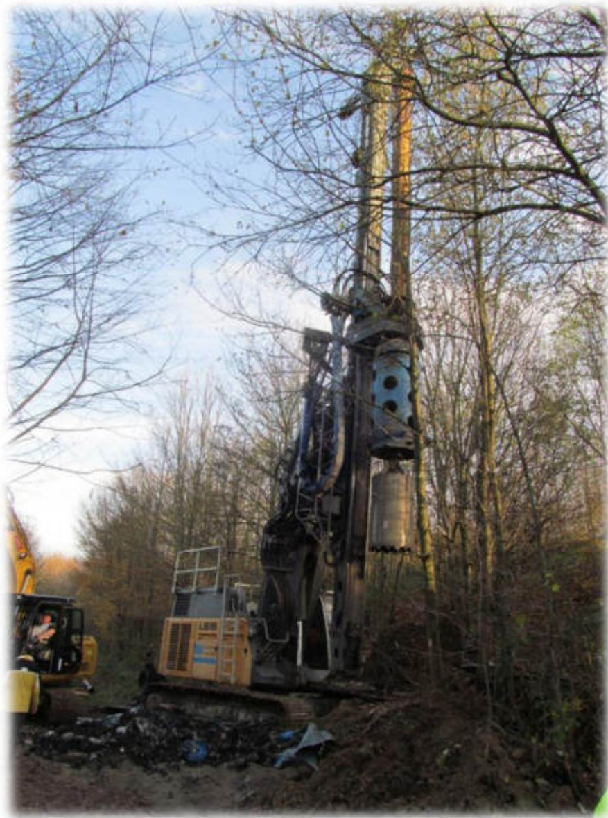
Optimierung Entgasung - Gasbrunnenbohrung
