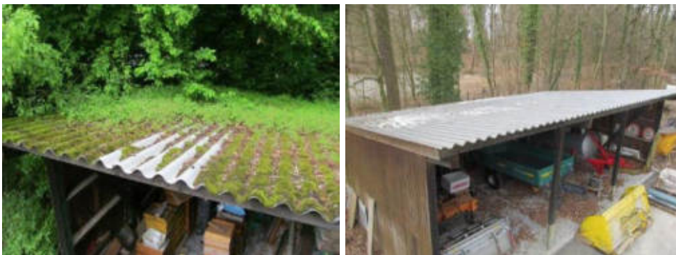
Abb. 4.3: Saniertes Asbestdach
