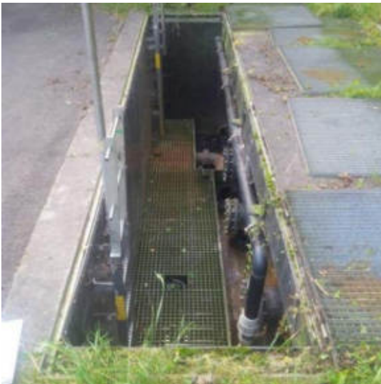
Abb. 4.5: Sickerwassersammelschacht
