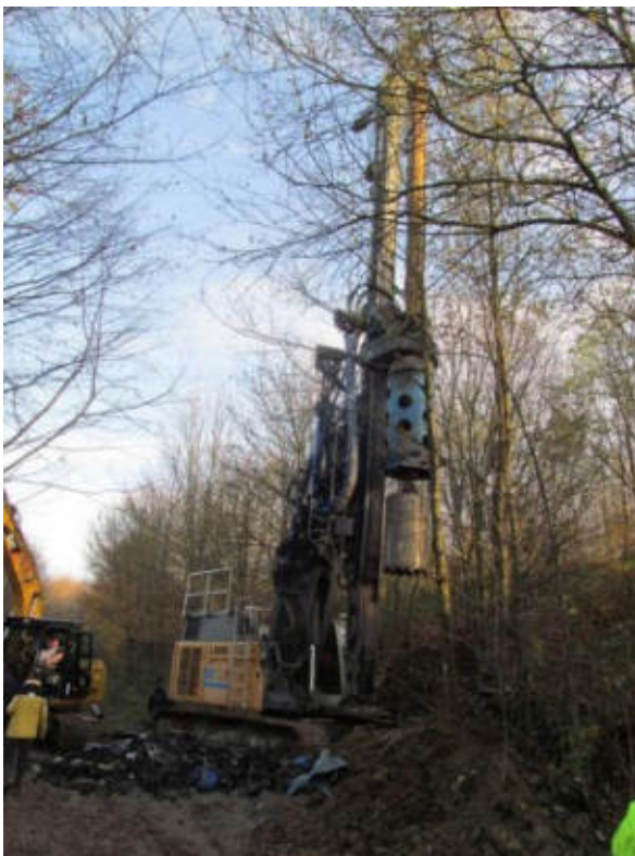
Abb. 4.10: Bohrung der Gasbrunnen
