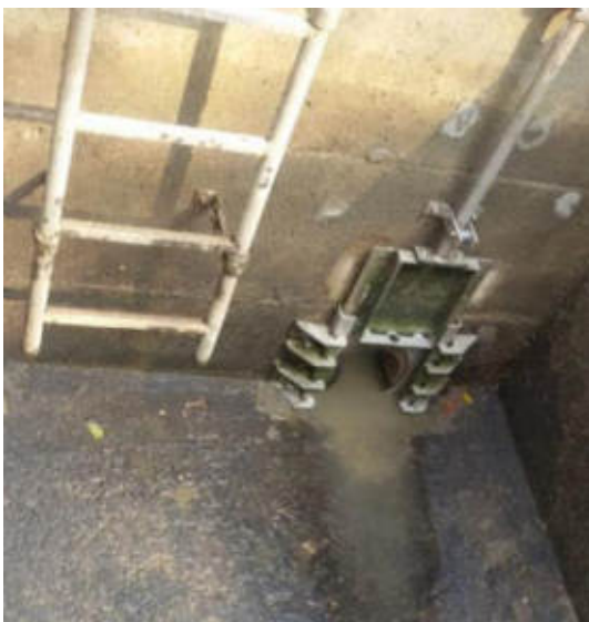
Abb. 4.7: Austausch defekter Schieber RRBalt
