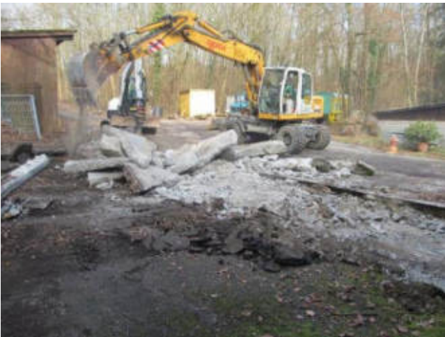
Abb. 4.1: Demontage Waschplatte Betriebshof
