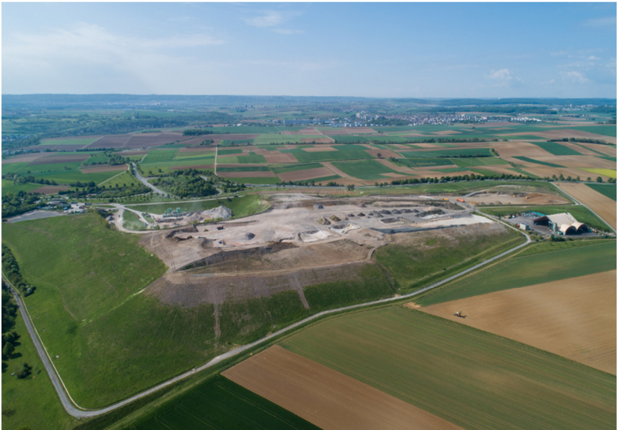
Abb. 1.1: Schrägaufnahme aus südlicher Richtung auf die Deponie Ende April 2020
