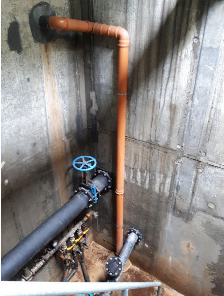
Abb. 4.5: Kontrollschacht des SiWa-Beckens, nachdem er abgepumpt wurde
