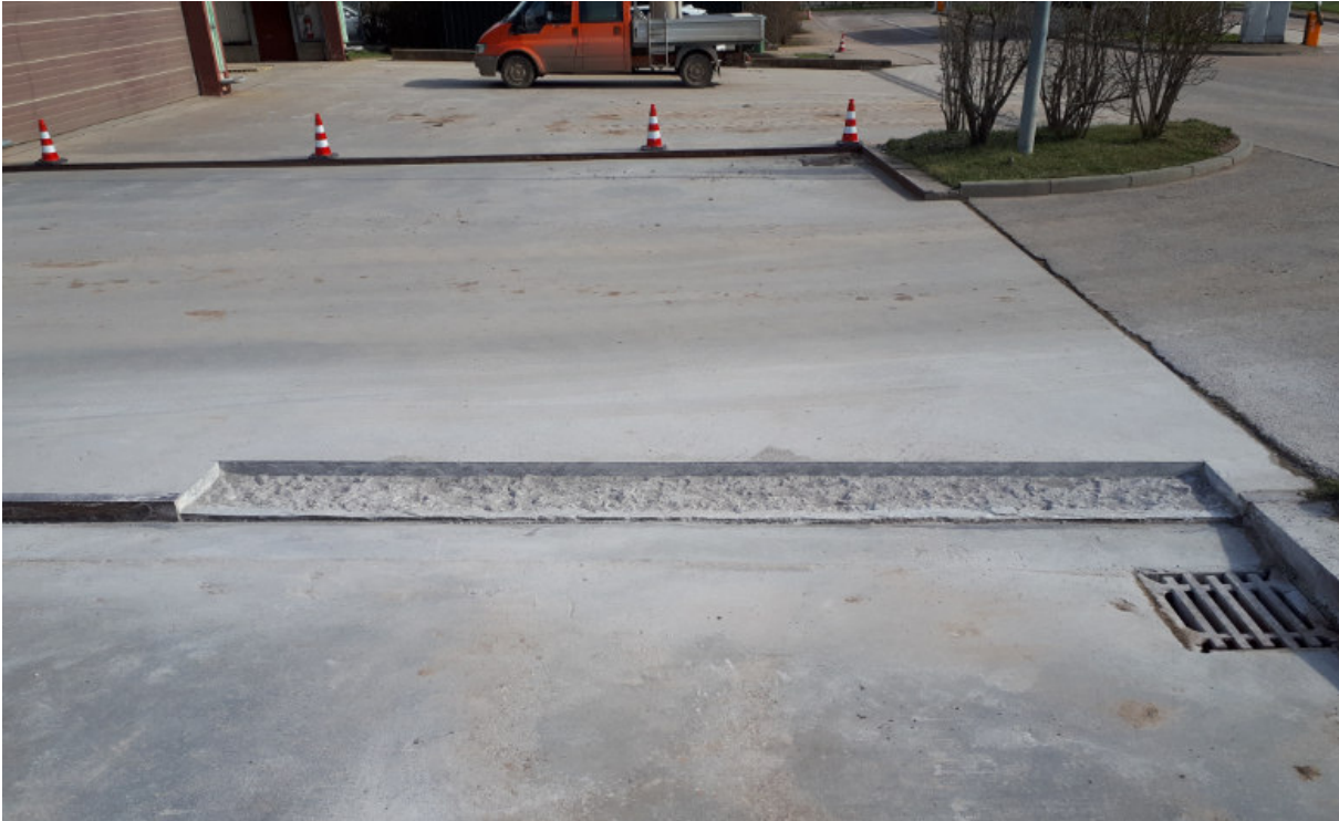
Abb. 4.4: Ausbesserung der Asphaltkante im Bereich der Werkstatthalle
