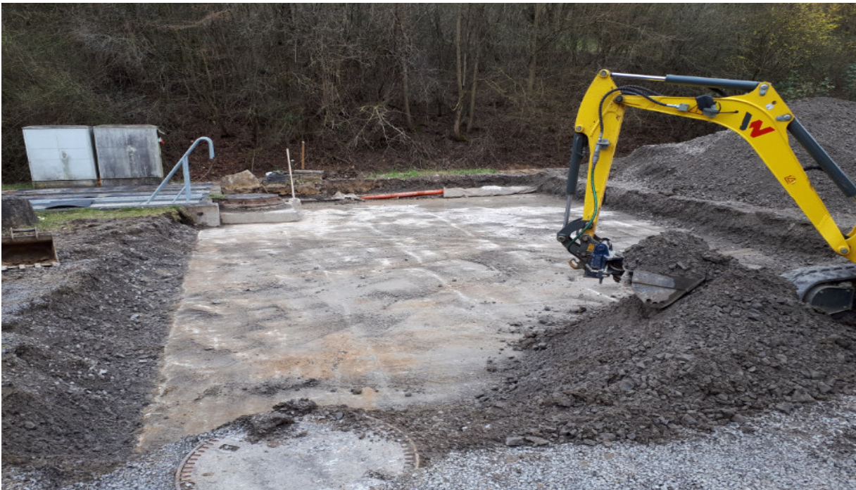
Abb. 4.2: Bauarbeiten am SiWa-Becken
