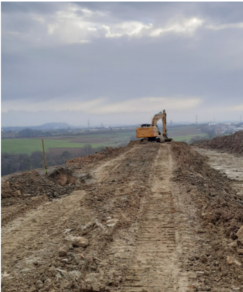
Abb. 4.1: Fortbau des Trenndamms 4 im Bereich DK 0 BA 3
