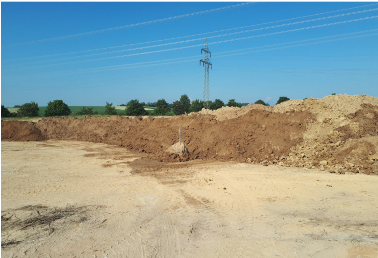
Abb. 4.3: Einbau von Rekultivierungsboden im DK 0 BA 5
