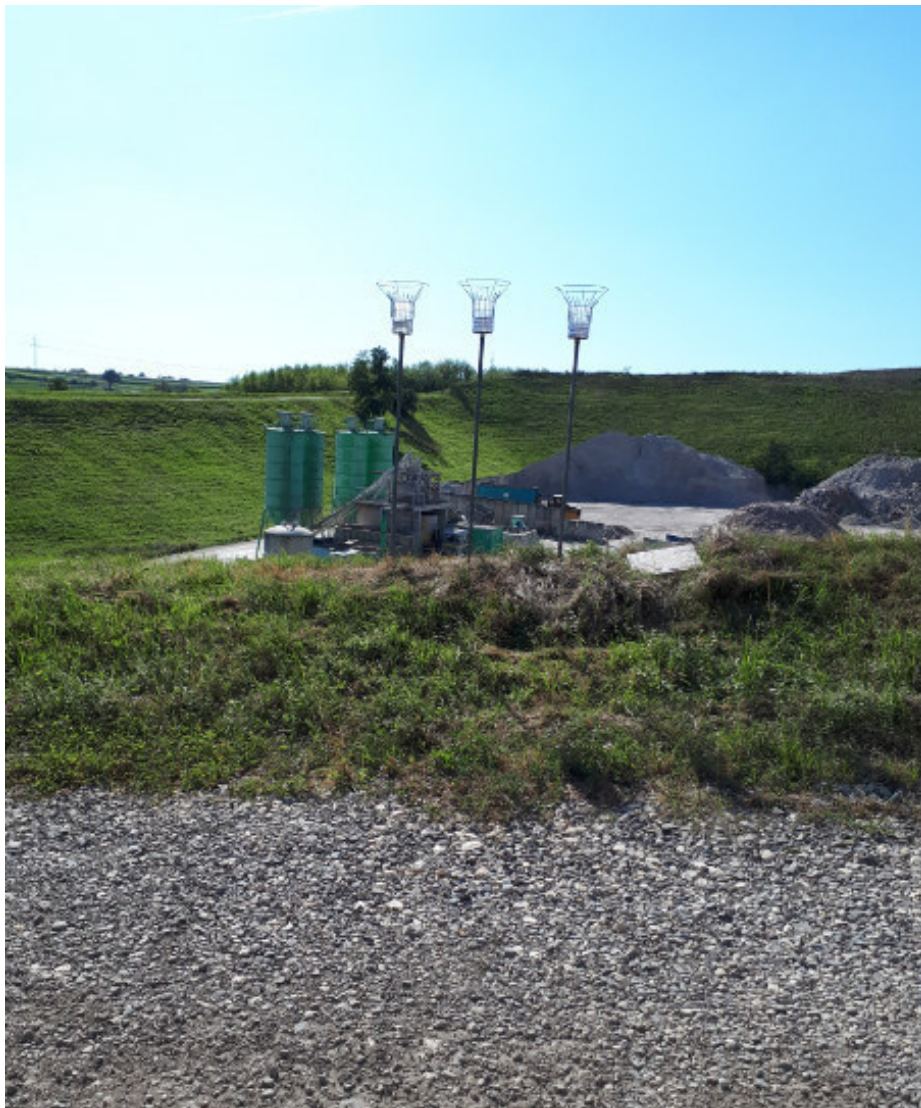
Gefäße zur Staubniederschlagsmessung im Bereich DK I BA 1
