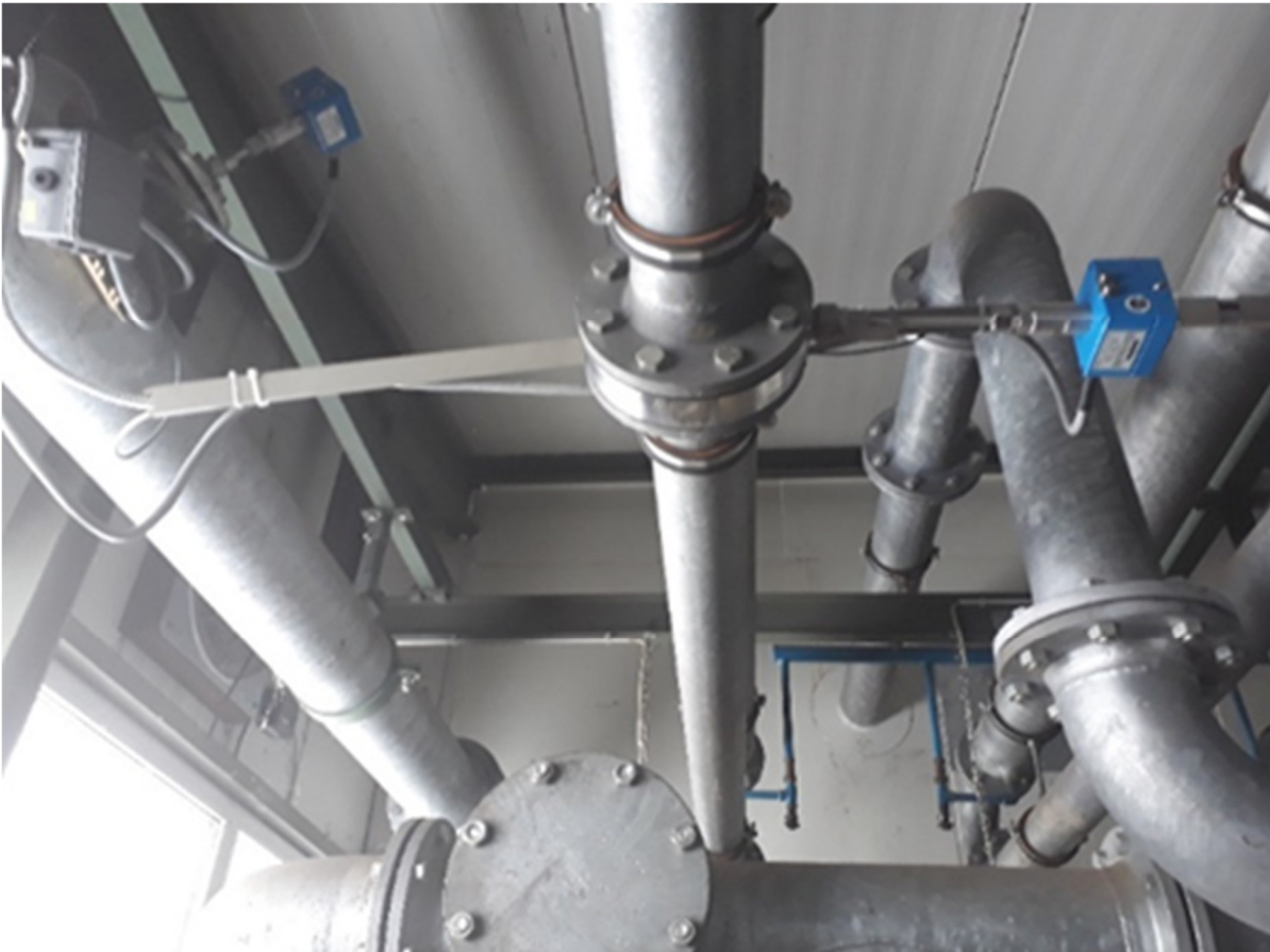
Abb. 4.2: Beseitigung Druckluftleckagen Verdichterstation
