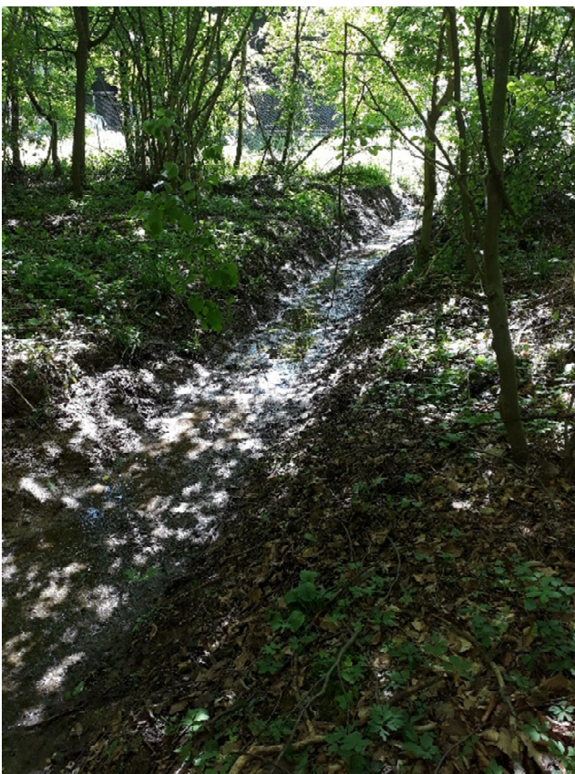
Abb. 4.5: Gesäuberter Auslauf Waidwiesengraben
