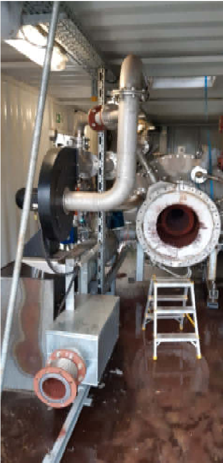
Abb. 4.4: Entfernung alter Wärmetauscher HTX-X
