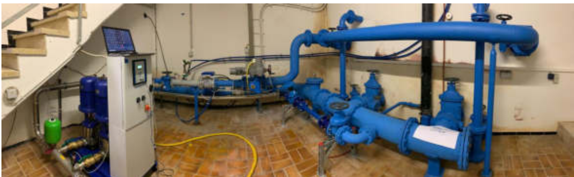
Abb. 4.3: Neue Armaturen
