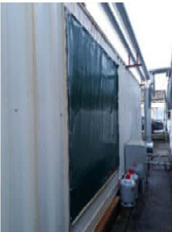
Abb. 4.1: Wetterschutzplane Container Schwachgasbehandlungsanlage
