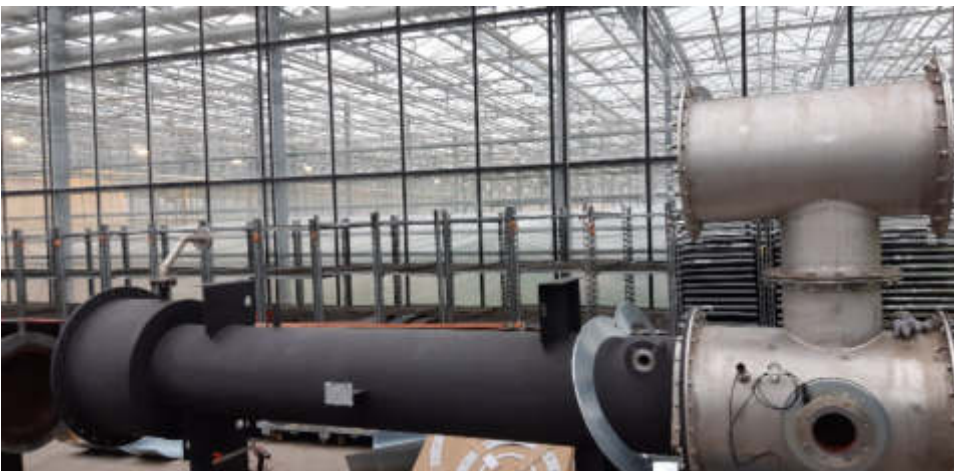
Abb. 4.5: Aufbau neuer Wärmetauscher
