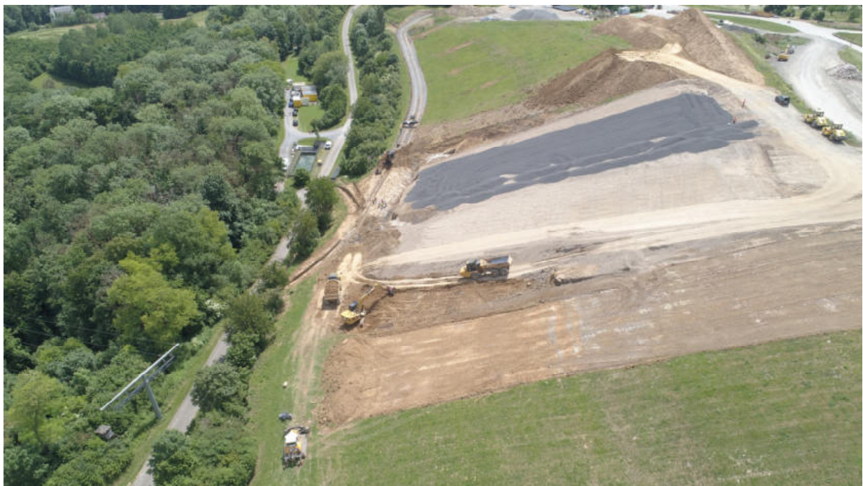
Abb. 4.6: Baumaßnahme Oberflächenabdichtung
