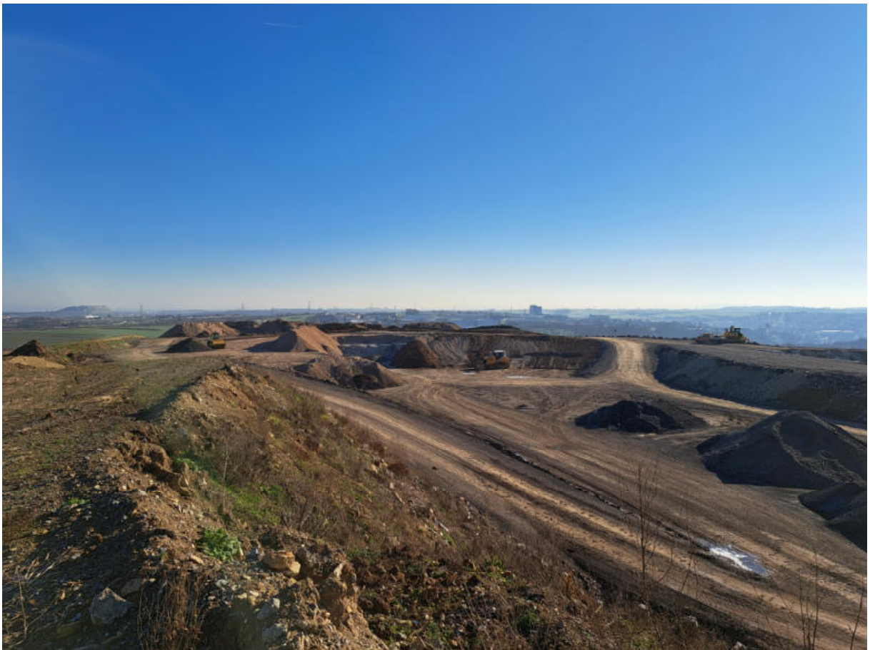
Deponie AM FROSCHGRABEN Einbaubereich DK I
