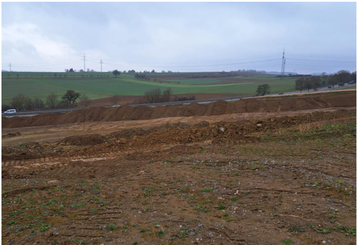
Abb. 4.2: Einbau der Rekusicht
