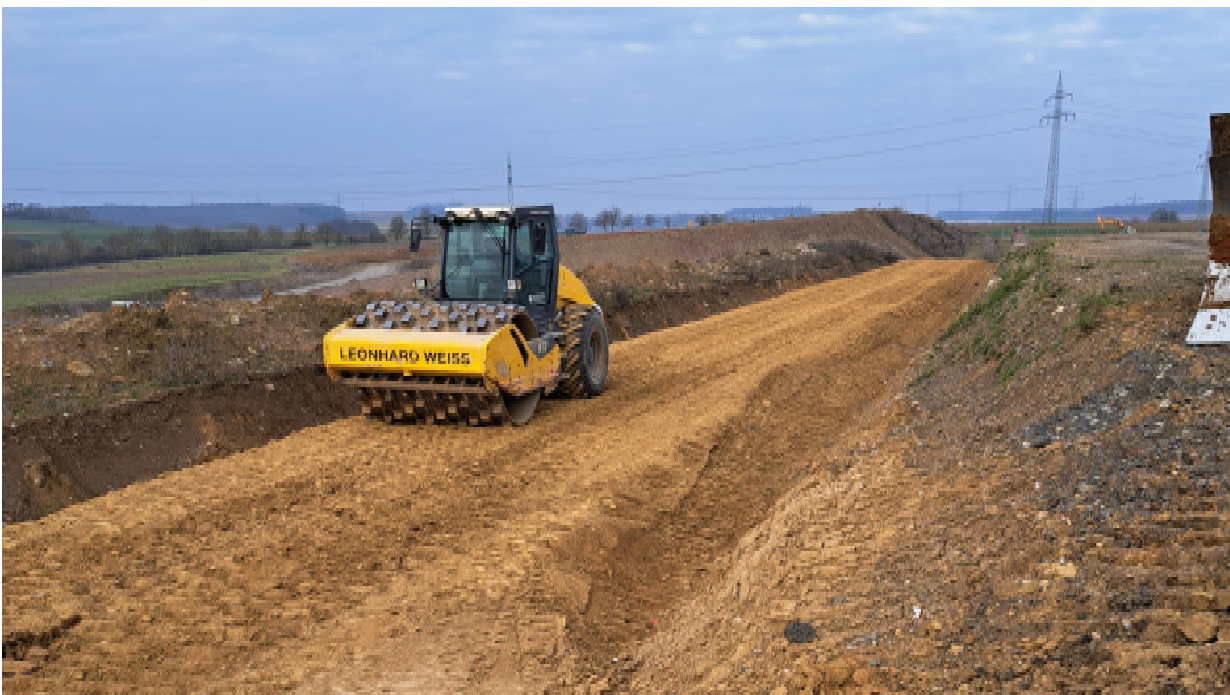
Abb. 4.1: Trenndammbau
