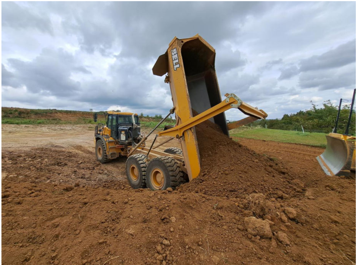
Abb. 4.2: Einbau der Rekultivierungsschicht
