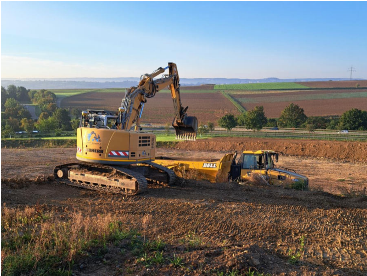
Abb. 4.3: Bodenabtrag mittels GPS-Bagger
