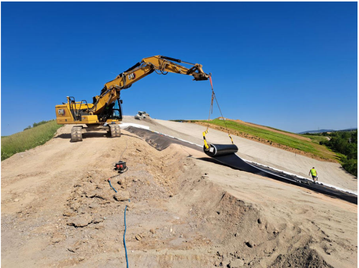
Deponie AM FROSCHGRABEN Oberflächenabdichtung RA1
