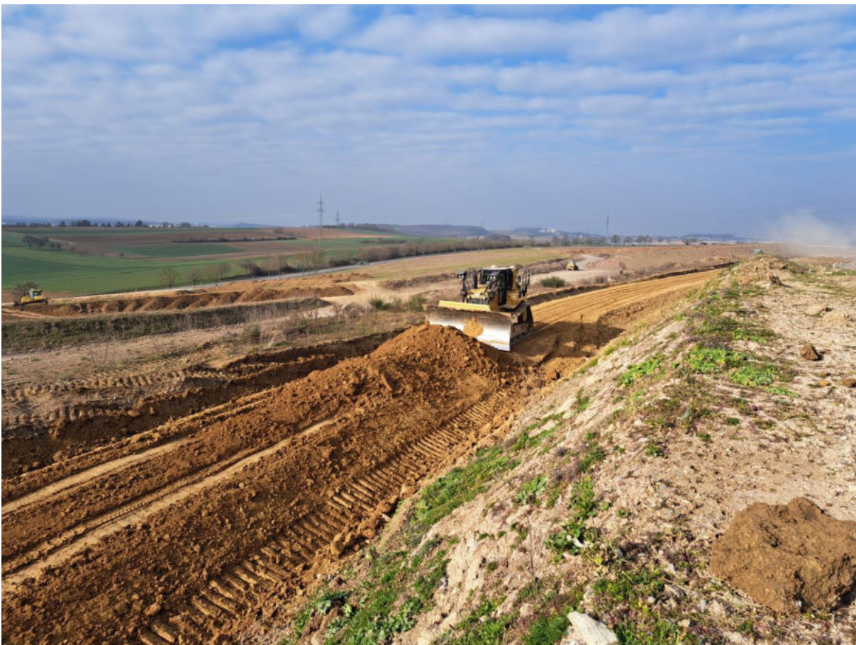
Abb. 4.1: Trenndammbau
