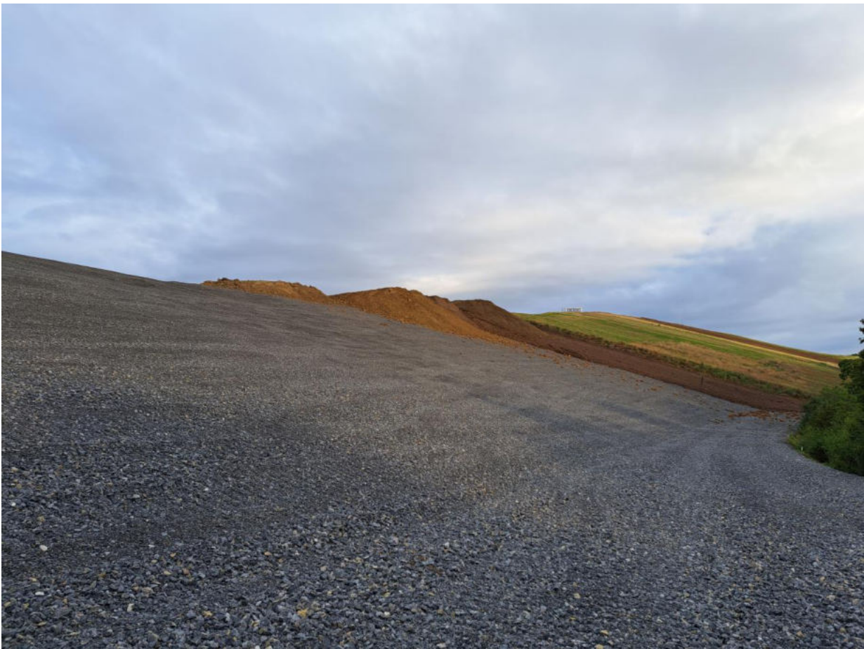
Abb. 4.5: Baumaßnahme Oberflächenabdichtung
