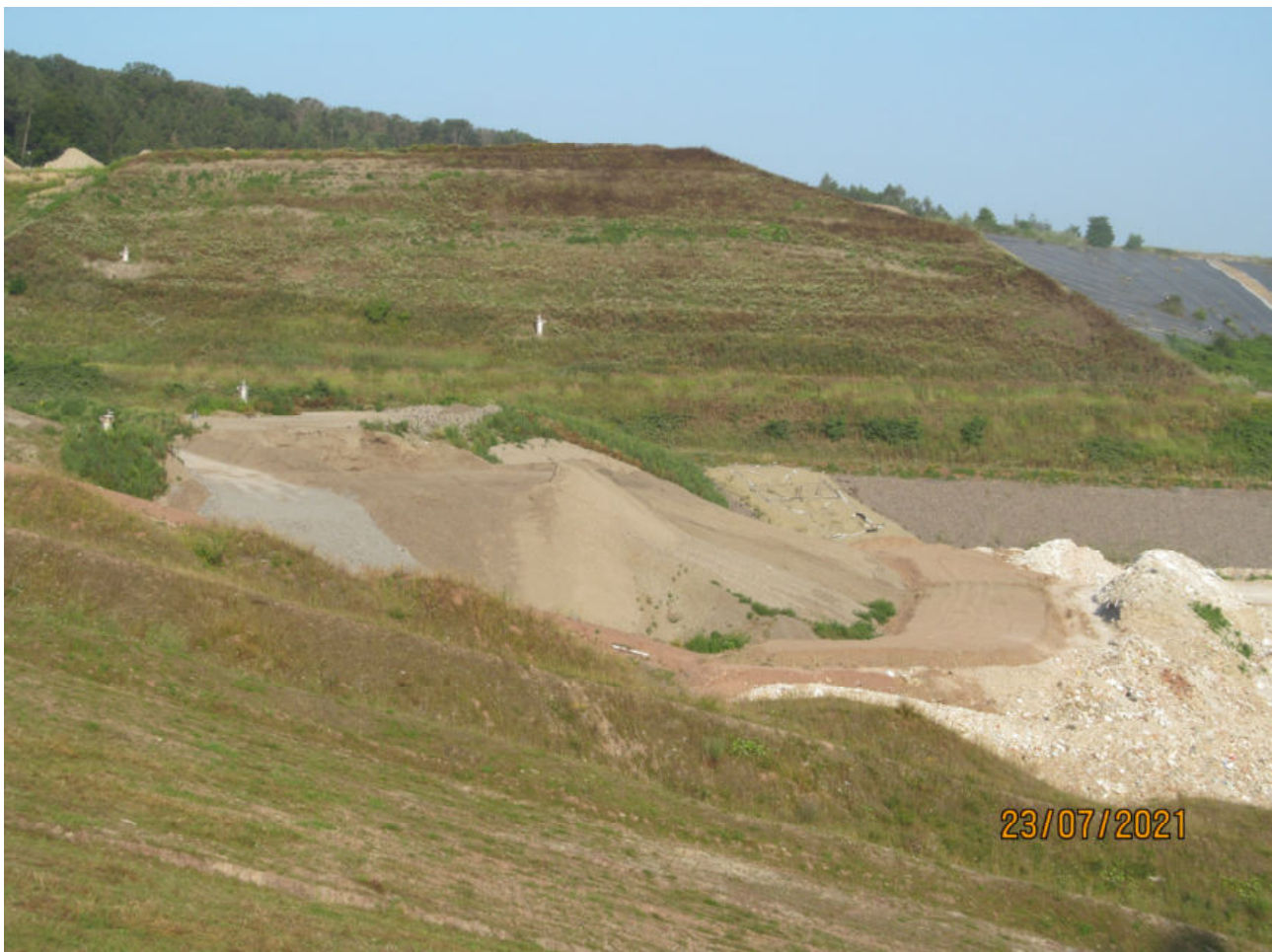
Abb. 4.1: Trenndamm zwischen DA X/1 Gips + Bauschutt und DA X/2 MBA
