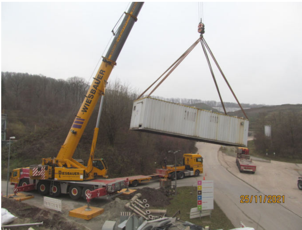
Abb. 4.3: Rückbau des alten BHKW
