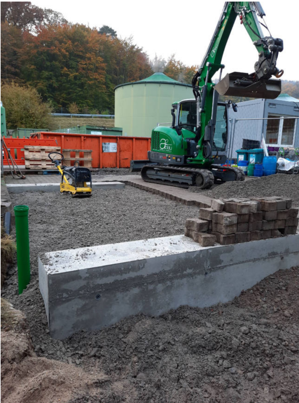
Abb. 4.5: Herstellung neues Fundament für Personalcontainer
