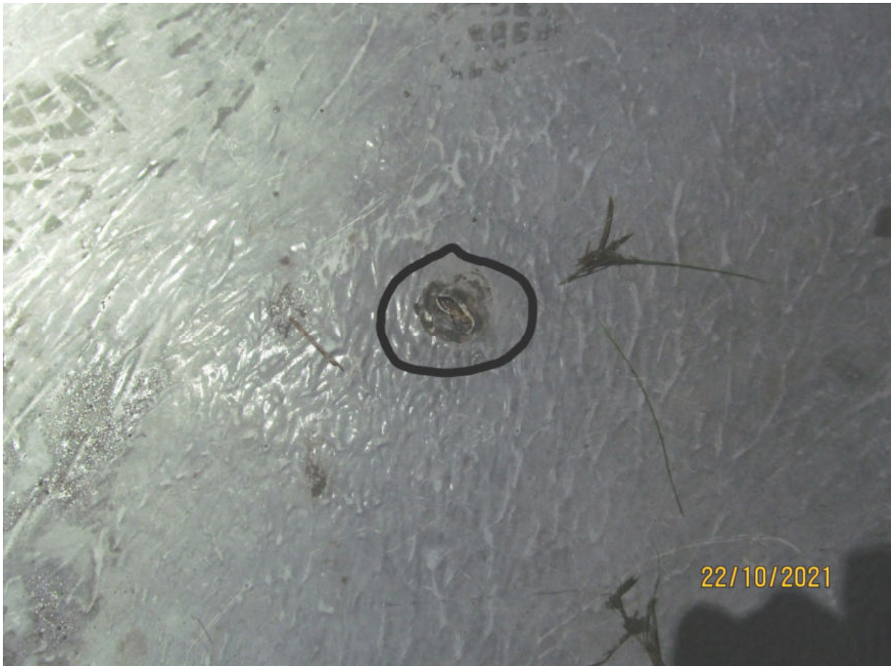
Abb. 4.2: Aufnahme vom Inneren des Vorspeichers vor der Sanierung
