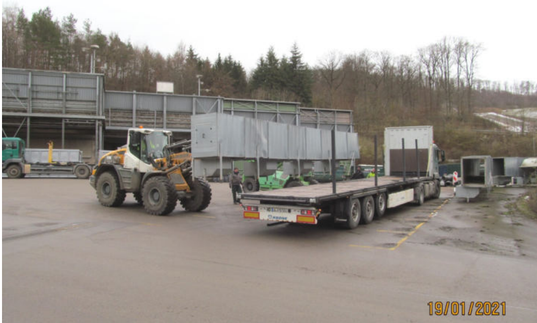
Abb. 4.7: Rückbau der Holztrocknung
