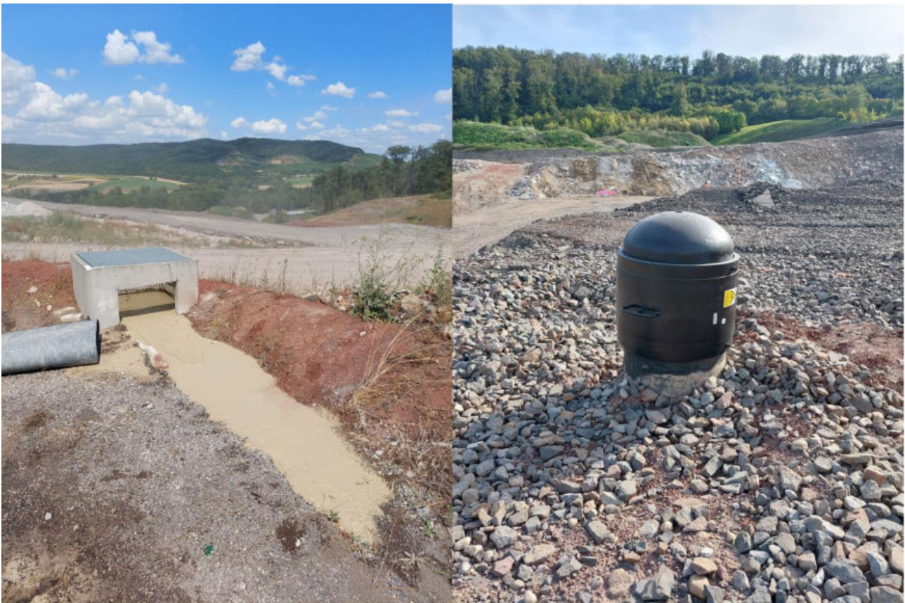
Abb. 4.6: Verfüllung der Leitung mit Spezialbindemittel (links) und aufgeschweißte Endkappe nach Verfestigung (rechts)
