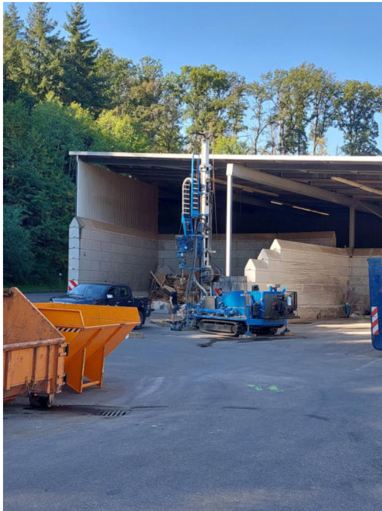
Bohrung an der Umladestation zur Erstellung eines Baugrundgutachtens
