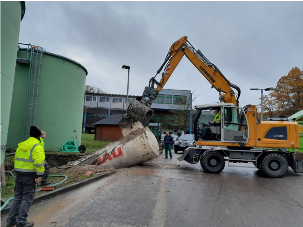
Abb. 4.7: Rückbau des unterirdischen Essigsäuretanks
