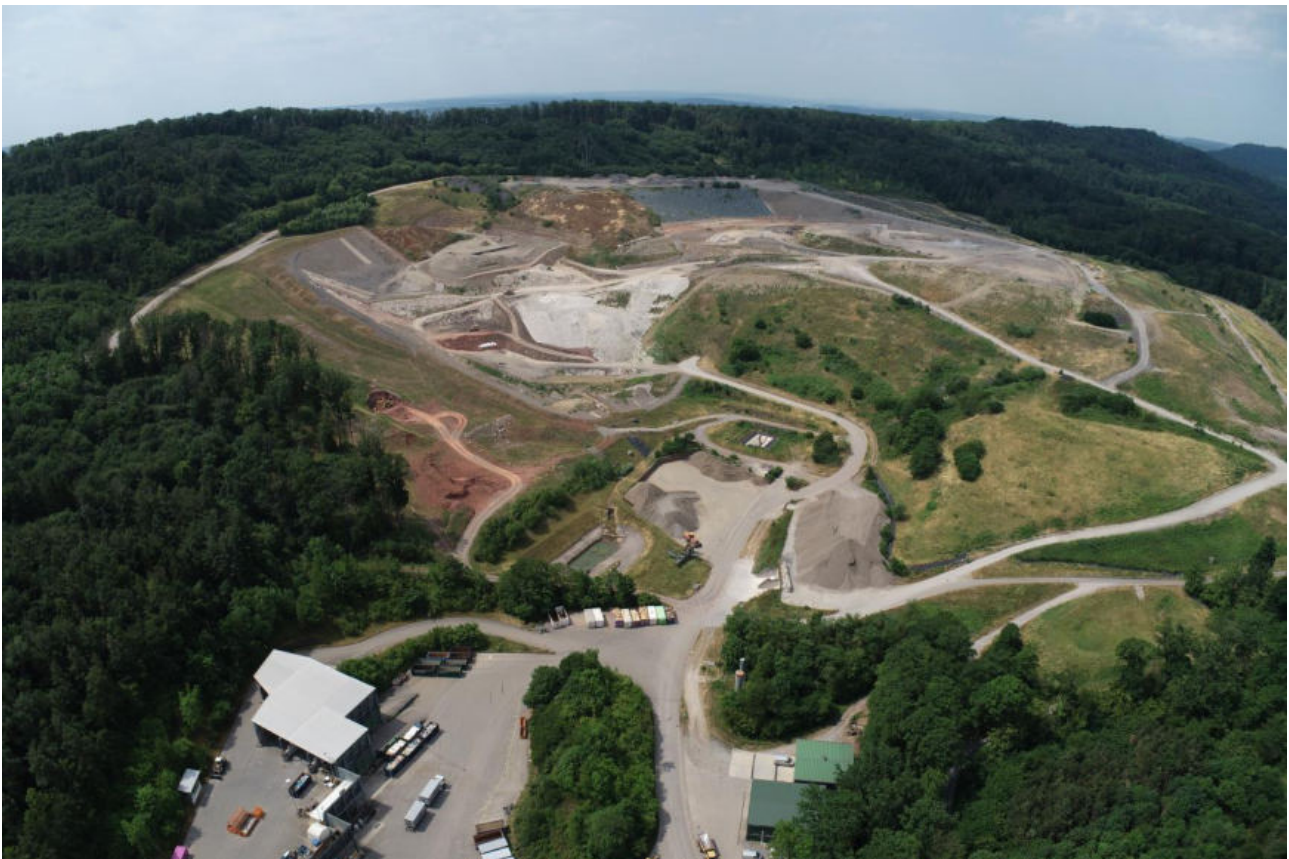
Abb. 1.1: Schrägaufnahme auf die Deponie im Juli 2023
