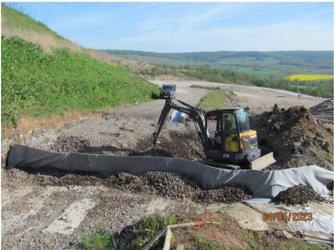
Abb. 4.2: angeschweißte Wasserleitbahn mit Schutzvlies im Bereich des Trenndamms
