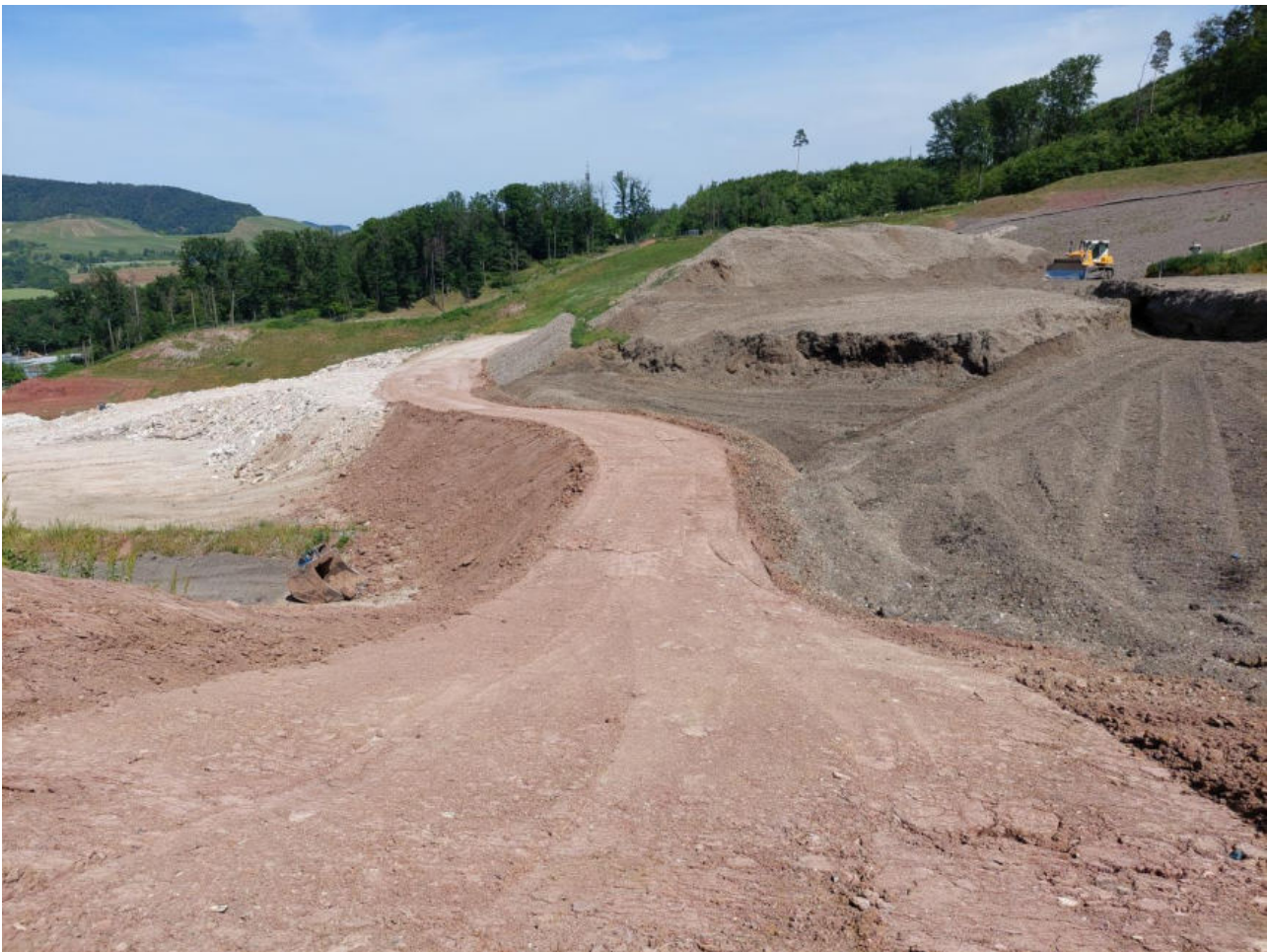
Abb. 4.1: Trenndamm zwischen den Flächen DA X/1 (DKII, gemischt +-Gips) und DA X/2 (MBA)
