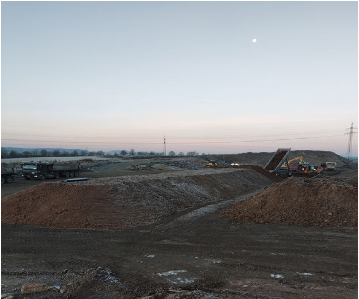
Errichtung von Bodenmieten mit Rekultivierungsboden im DK 0 BA 4.1
