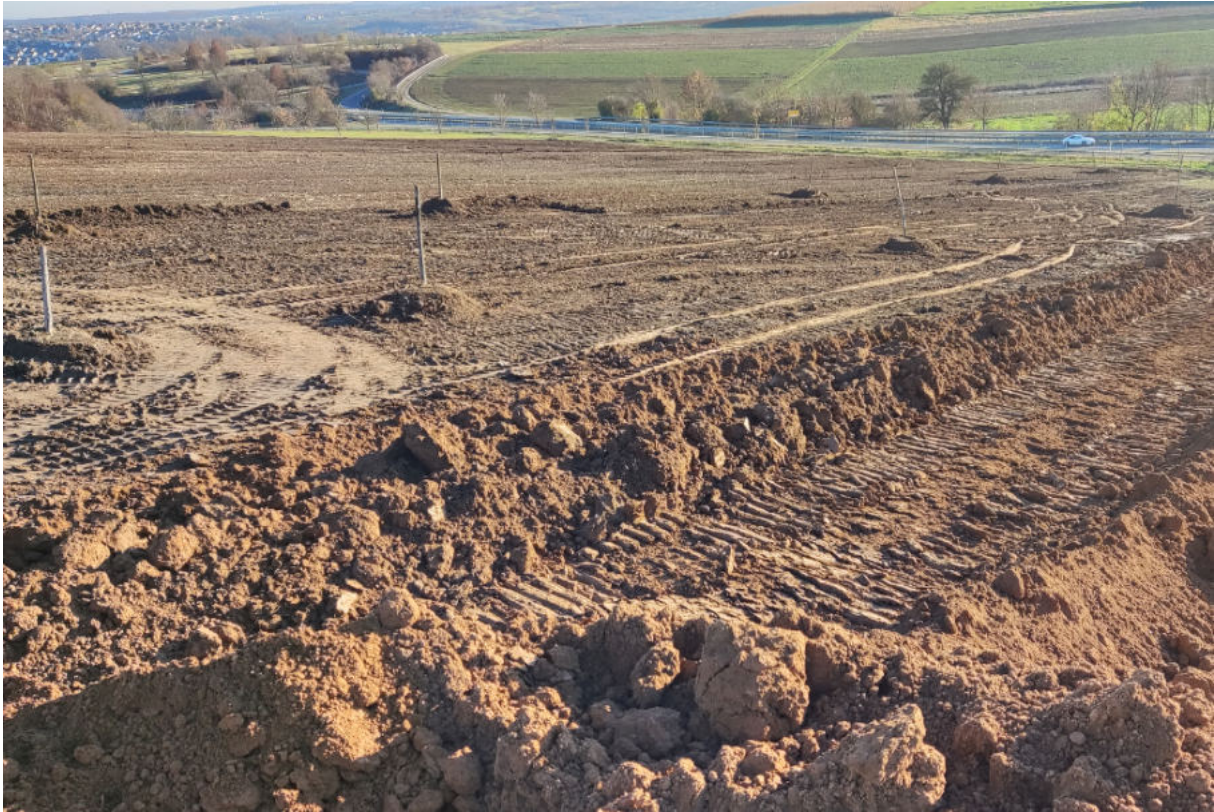
Abb. 4.4: Blick über die Fläche der ehemaligen Kurzumtriebsplantage im ED BA 2 nach Abschluss der Rodungsarbeiten
