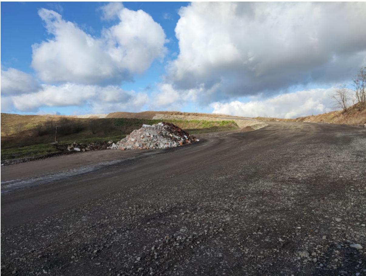
Abb. 4.1: Ausbau des Hauptzufahrtsweges im Bereich DK I BA 1 und 7
