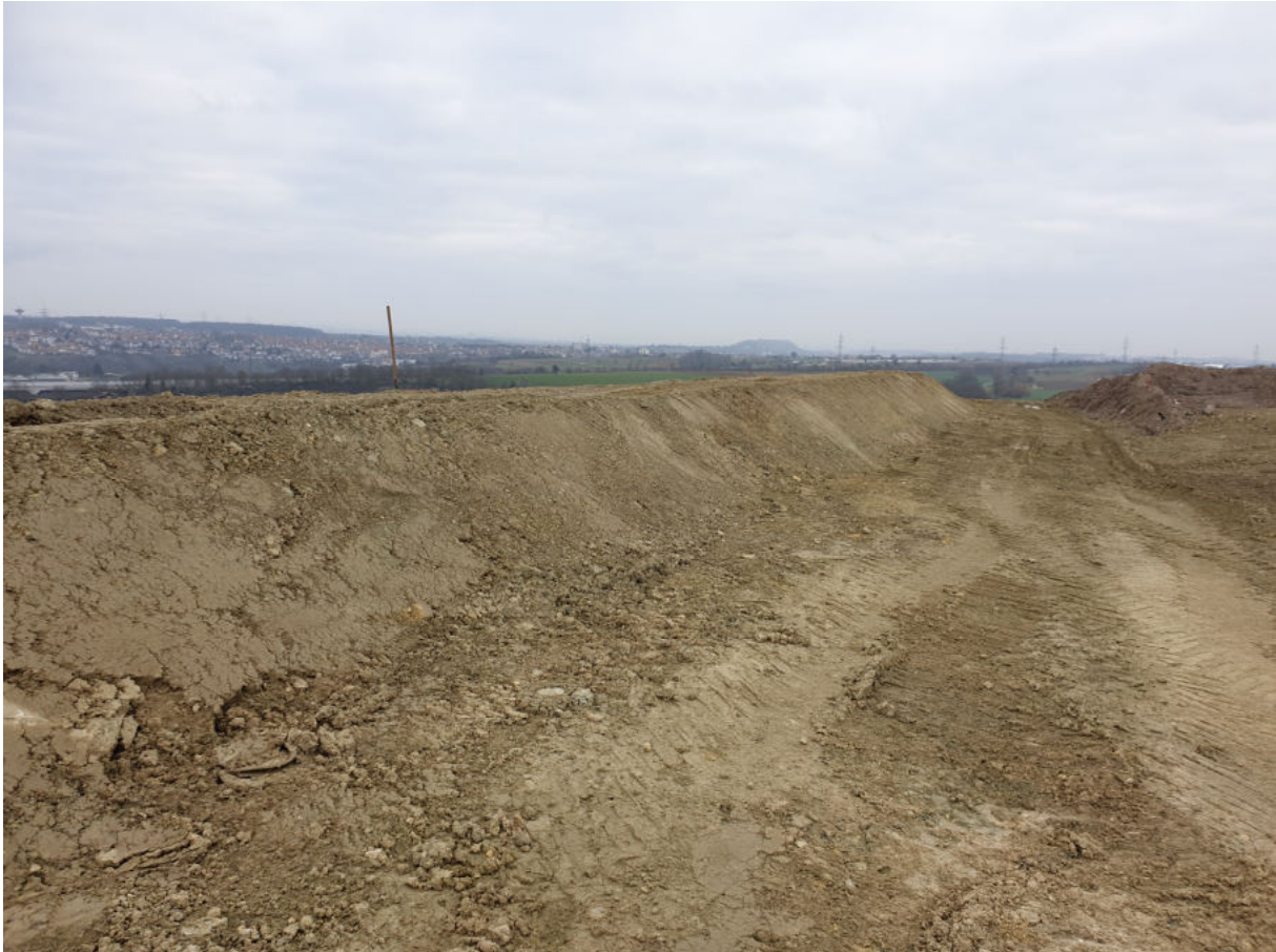
Abb. 4.2: Abgeschlossener Trenndamm im Bereich DK 0 BA 3 (Richtung Ostböschung)
