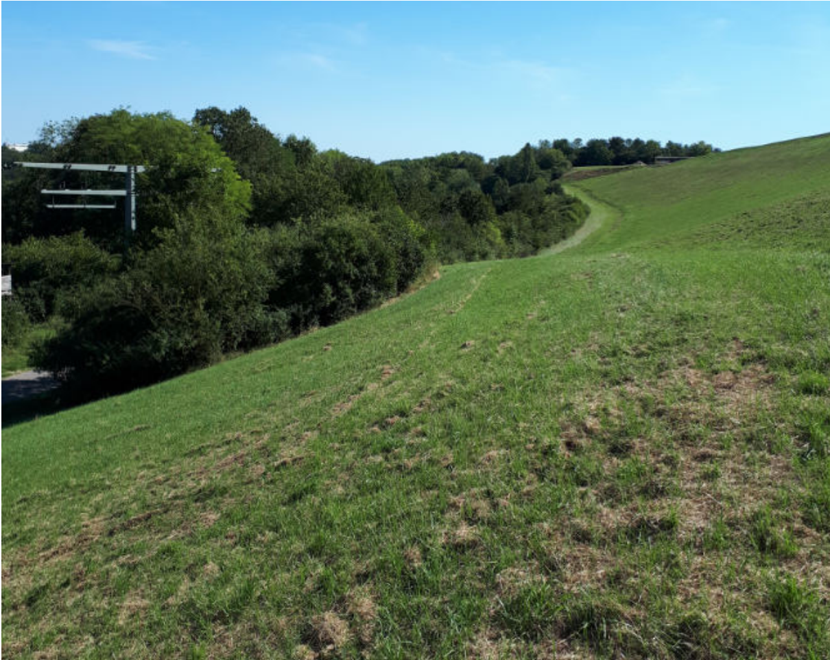
Abb. 4.5: Blick auf den teilweise zu rodenden Baumbestand im RA 1 DK I (Ostböschung)
