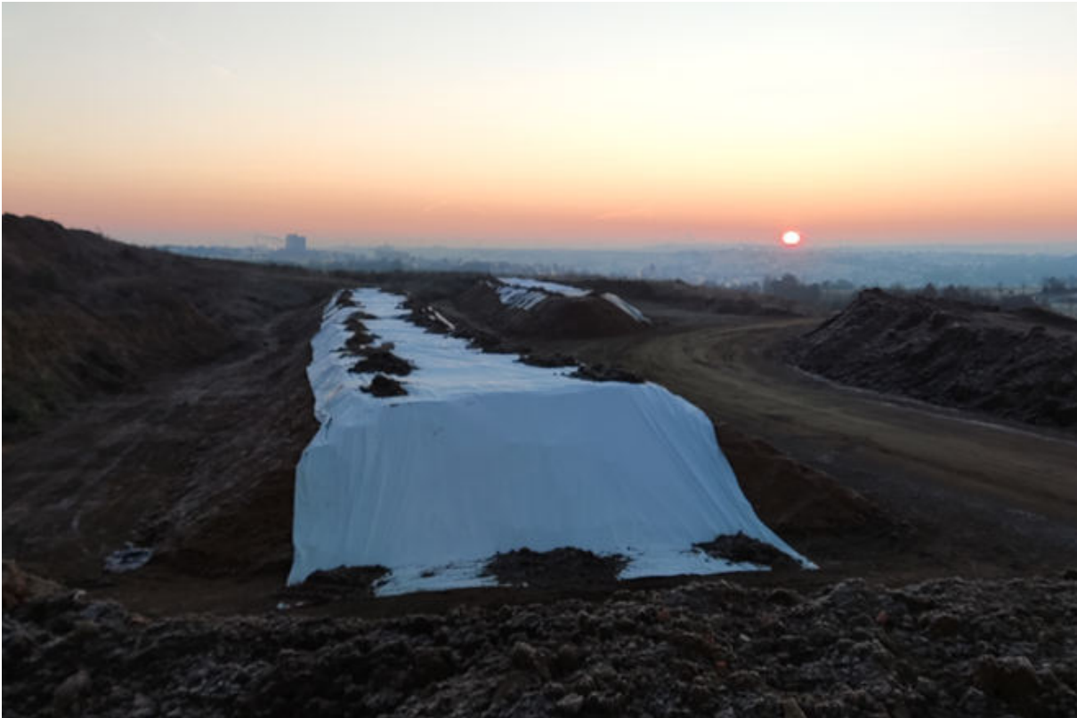
Abb. 4.3: Mit Folien abgedeckter Reultivierungsboden im ED BA 2
